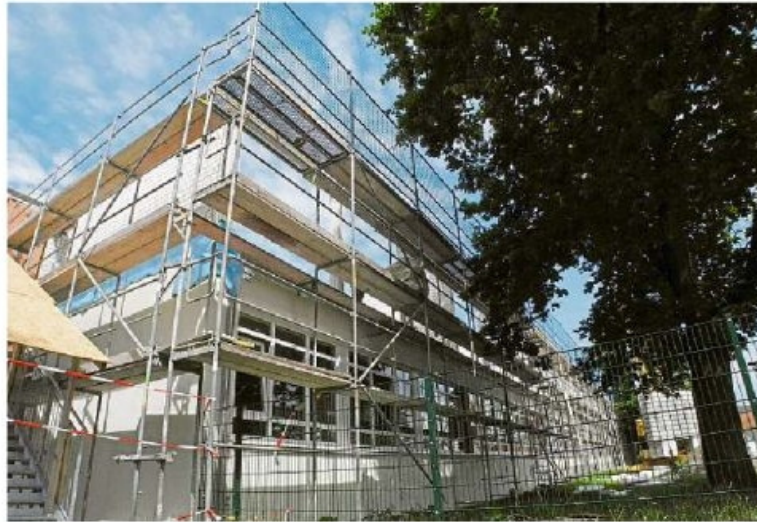
Die Gesamtschule im Norden Warendorfs. Die Bauarbeiten sind längst abgeschlossen. Insgesamt 3,5 Millionen Euro sind seit 2009 in den Schulstandort an der Kapellenstraße geflossen, davon 1,4 Millionen Euro für die damalige Hauptschule. Erst 2011 beschloss der Rat die Einrichtung einer Gesamtschule. Seitdem sind laut Bauverwaltung allein 2,1 Millionen Euro investiert worden.
